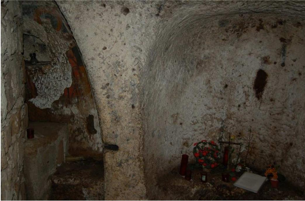
*Fig. 7.2 – Dettaglio dell'area presbiteriale (a sinistra l'abside A2, a destra l'abside B3); sulla sinistra si notano le fondazioni della chiesa rinascimentale, che poggiano su un gradone in muratura.*
