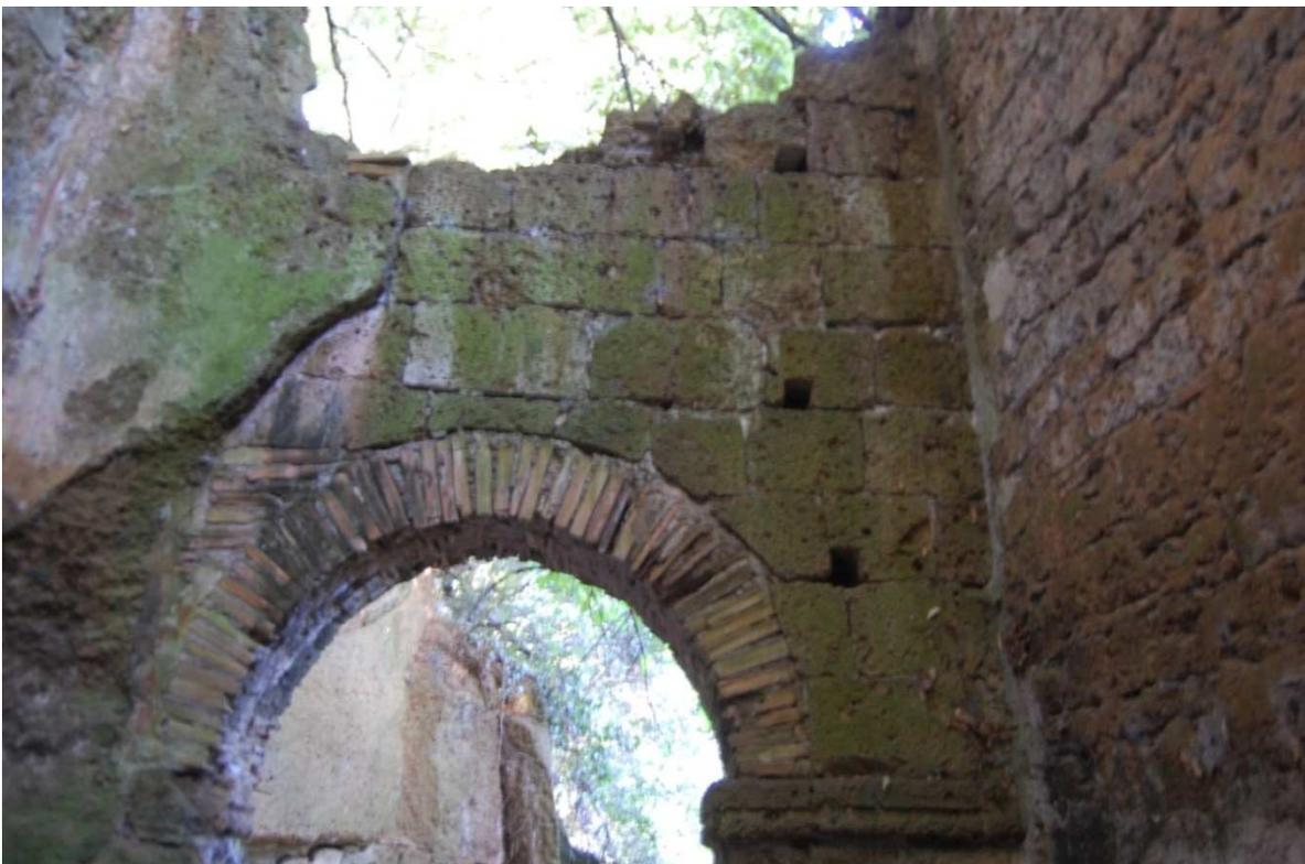
Fig. 10.3 – Ambiente D. Muratura a filari isodomi della chiesa romanica (a sinistra, sotto divisorio tra la navata centrale e la navata destra) e muro di fondo della chiesa rinascimentale.
