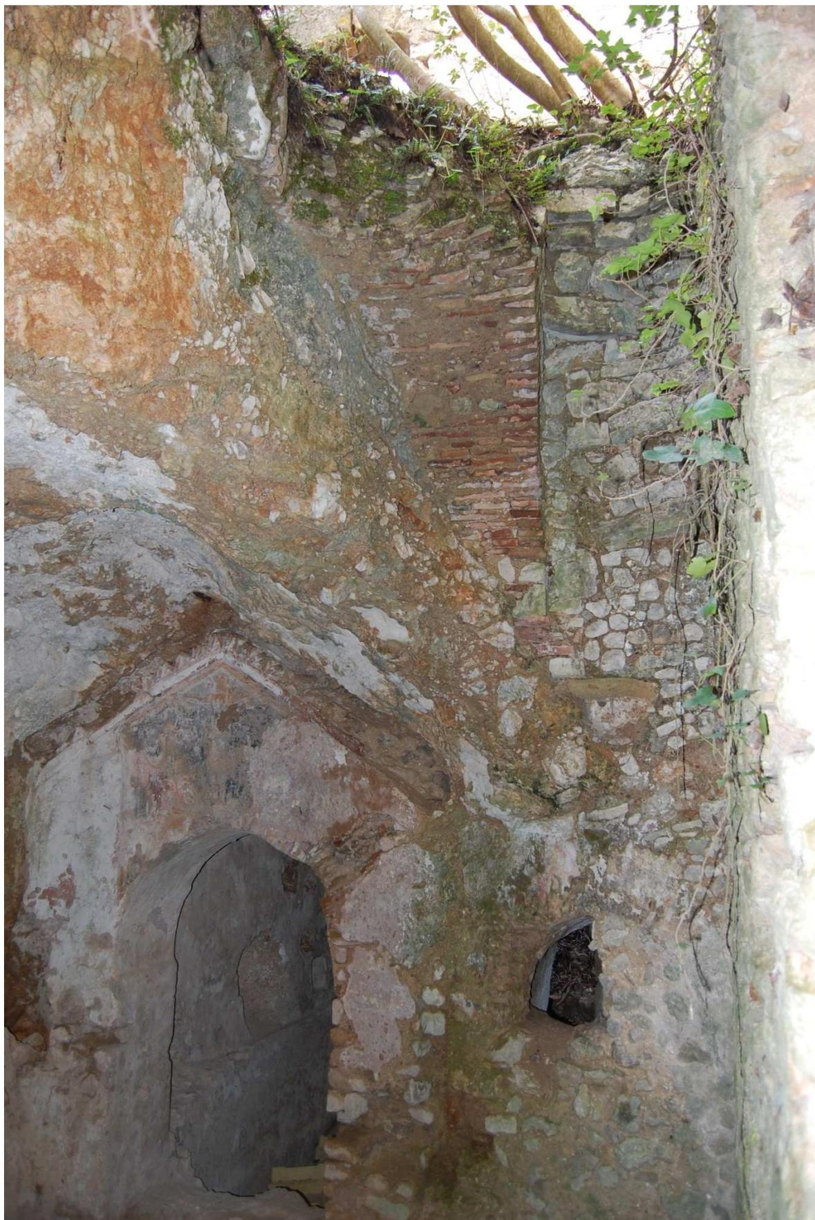
*Fig. 19.5 – Le sostruzioni sul lato O dell’ambiente principale; sulla sinistra l’arco di accesso a B1, sulla destra l’arco tamponato di B2, e a lato il muro di sostruzione N.*
