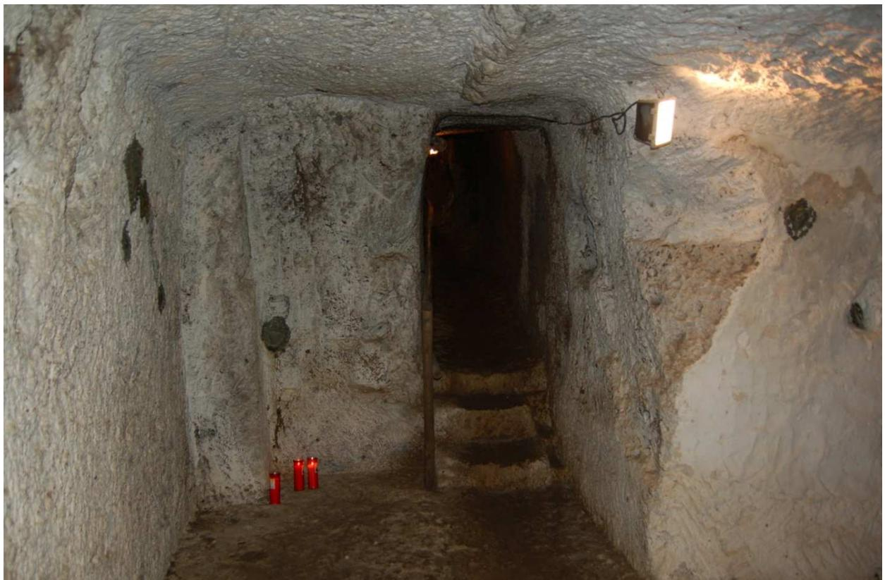
*Fig. 2.3 - Lo sbocco del cunicolo A; in alto si nota la traccia della volta originaria del cunicolo, in basso le tracce di sottoescavazione dell'ambiente.*
