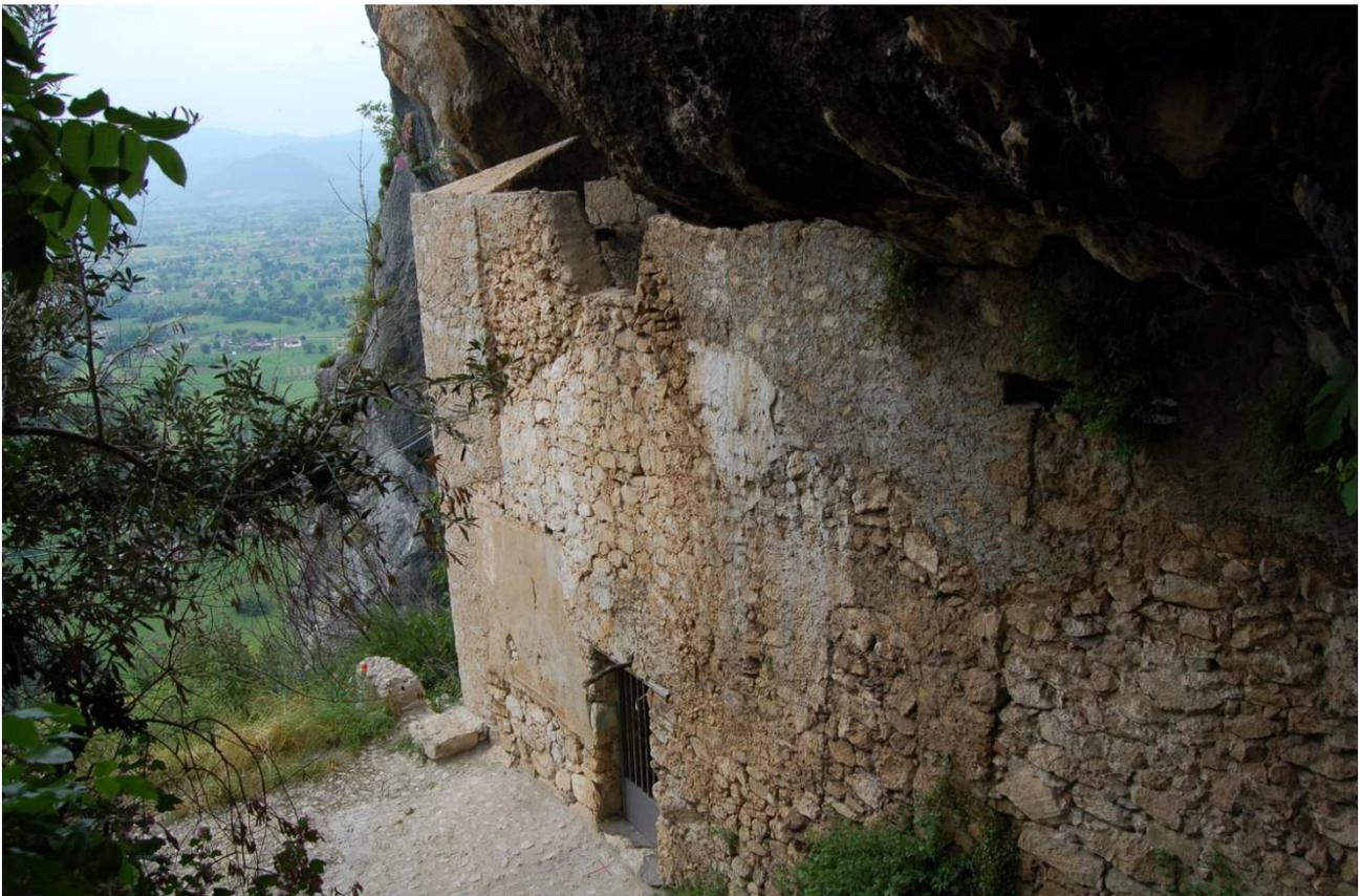
*Fig. 31.2 – Le strutture murarie della facciata. Si notano bene il contrafforte-campanile a SE, le tracce della facciata originaria, e, sulla destra, la finestra tamponata e il muro che chiude l'ossario.*
