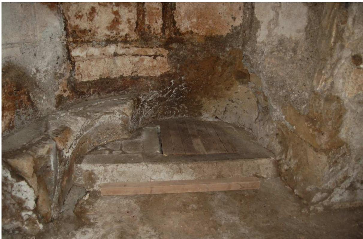
*Fig. 20.5 – Strutture murarie nell'abside di destra. Si nota il bancone, in parte demolito per l'apertura del tombino, e il gradone in muratura aggiunto in età moderna.*
