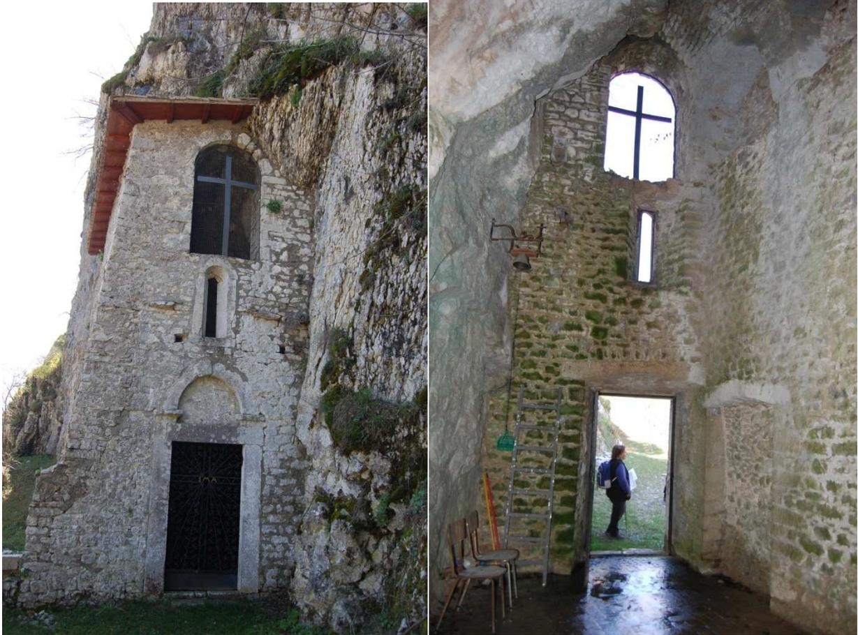
*Fig. 20.2 e 20.3 – Avancorpo A dall'esterno e dall'interno. Nella seconda foto è ben visibile il piano d'imposta della sopraelevazione settecentesca.*
